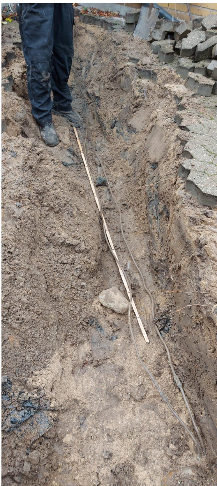
Billede 2: Den frigravede rørledning. Set mod vest.
