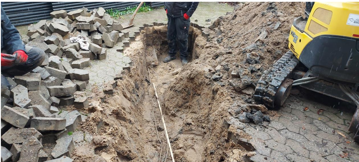
Billede 2: Den frigrauede rørledning. Set mod øst.
